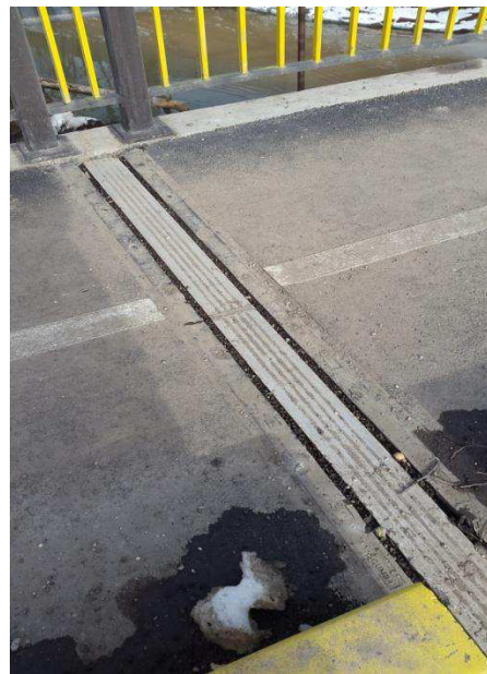
Foto: Instalare dispozitive tip Gumba BJ50 – Pod Calea Moinesti - Bacau
