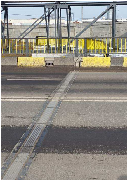
Foto: Instalare dispozitive tip Gumba BJ50 – Pod Calea Moinesti - Bacau
